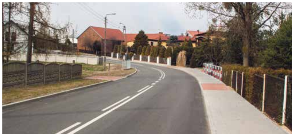
Zmodernizowana ul. Lipowa w Psarach
