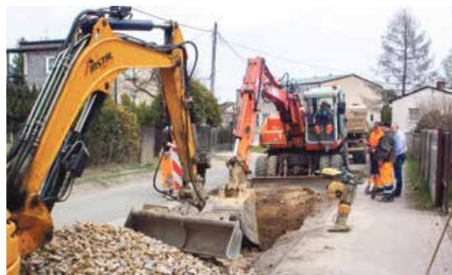
Budowa kanalizacji w Ligocie Woźnickiej
