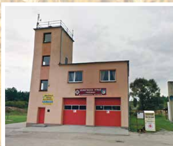
Kamieńskie Młyny, remont strażnicy OSP
