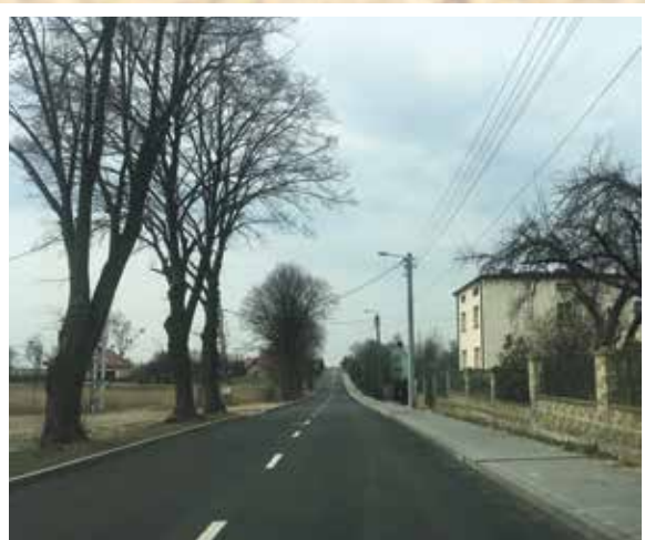
Psary, przebudowa ul. Lipowej
