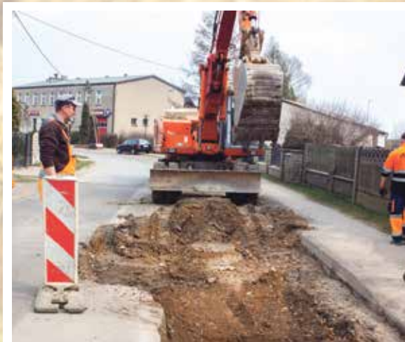
Ligota Woźnicka, budowa kanalizacji sanitarnej
