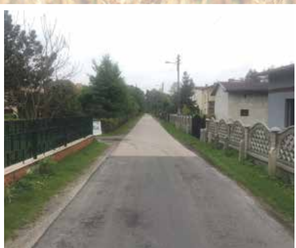
Dyrdy, nakładka bitumiczna przy ul. Leśnej
